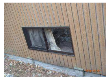
破損ガラス窓・復旧
