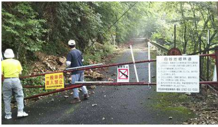
池郷林道ゲート左側崩落
