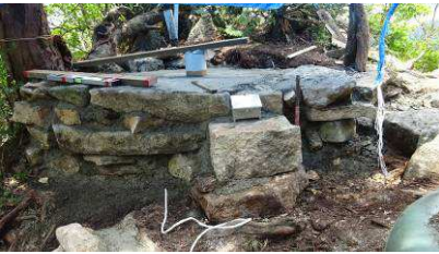
略完成の石組み台座を撮る
