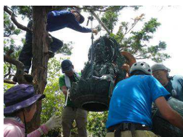
レバーブロックで座像を吊り上げ
