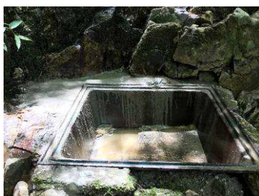
鉄箱周囲を目詰りセメント補修と補修後
