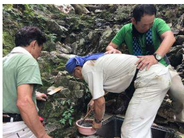
鉄箱周囲を目詰りセメント補修と補修後
