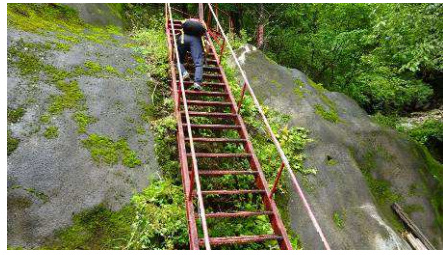
階段周りの整備
