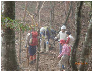
トラロープの張替え
