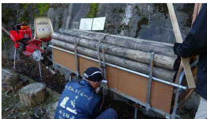
栈木丸太をモノレールで運搬し終点で降ろす
