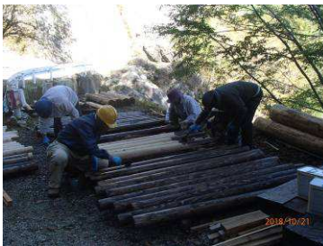
栈木丸太に皆で防腐剤を塗る
