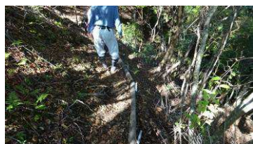
「くい丸」と防腐剤塗布栈木丸太で補給路の補修
