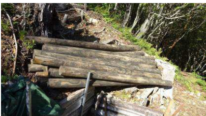
栈木丸太をモノレールで運搬し終点で降ろす
