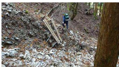
杉植林帯を通る捲き道は、猪がミミズ等の餌を捜し道の凹凸が激しく、トンガ・ジョレンで均す。浮いた桟木は、木杭と桟木を塩川君が大ハンマーで叩いて、土留めになる様に補修する。この地点を過ぎた支谷は、豪雨により約2m掘れ込んでいたので
