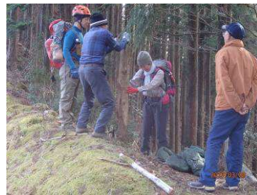
道標の標柱設置
