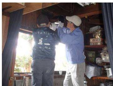
カマド煙突の防火対策配管作業
