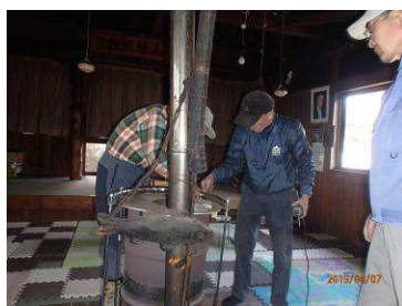
ストーブ火傷防止柵取付け
