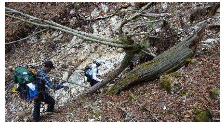
2カ所目の崩落現場
