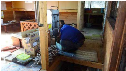
ストーブの補修
