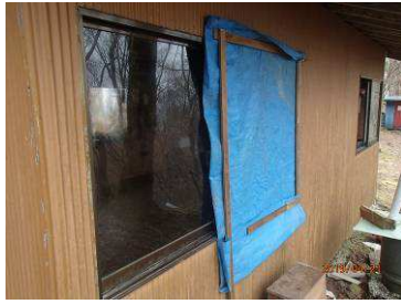
破損窓にシート張る
