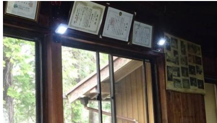
LED照明灯を設置
