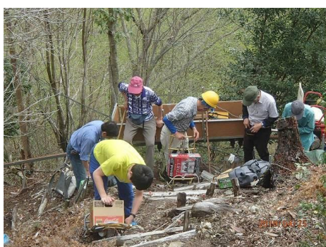
荷揚げの荷造り
