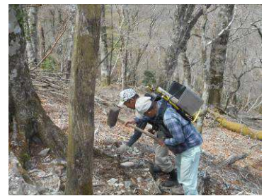
北面・木製段差の補修
