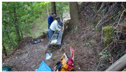
背板の施工中
