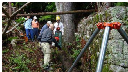
チェーンブロックで吊り上げ 切断
