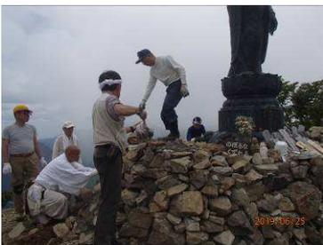
石積み隙間にコンクリート詰と練り作業
