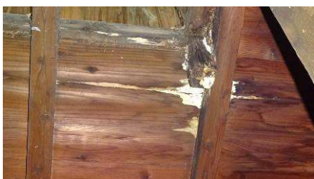
煙抜きの天井部分
