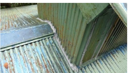
煙抜き隙間にコーキング
