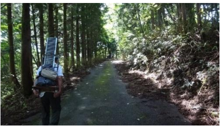
グレーチング板を運ぶ
