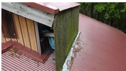
撤去前の板囲い
