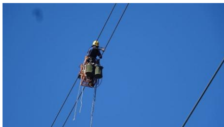
送電線工事中
