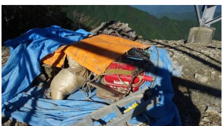
残されている工事機材
