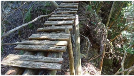
撤去前の丸木橋
