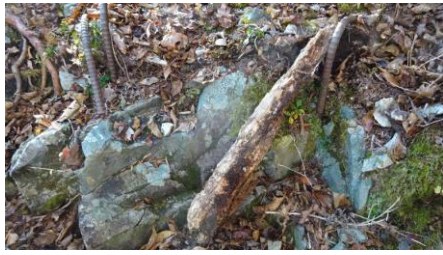
栈木が腐っている
