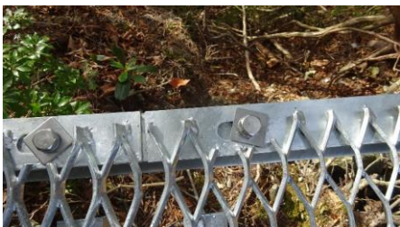
ステンレスボルトに交換
