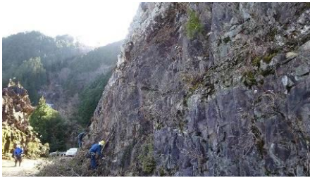
林道法面工事中
