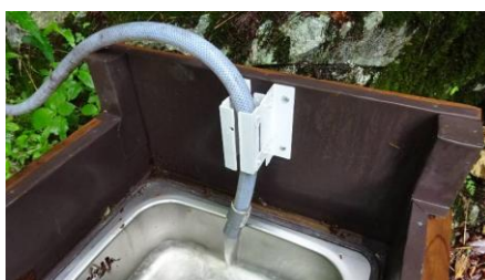
水場のホースに金具取付
