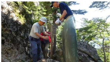
摩看板の設置作業
