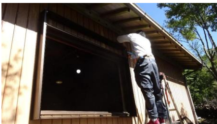
雨戸枠の取り付け
