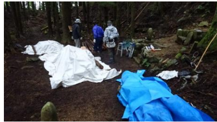
運び上げた資材にシート
