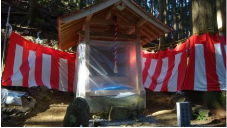
完成した地藏堂
