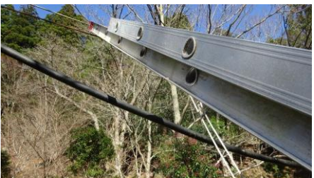
導水ホースの弛み修整
