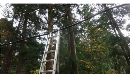
導水ホースの弛み修整
