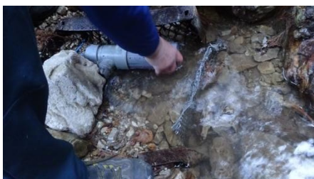
穴あきパイプを差し込む
