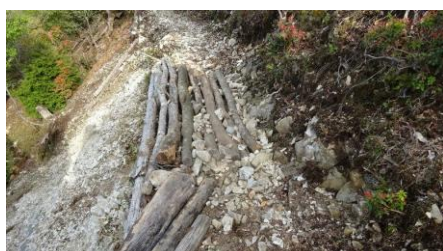
穴が補修された補給路
