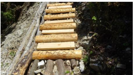
横木取り付け完了
