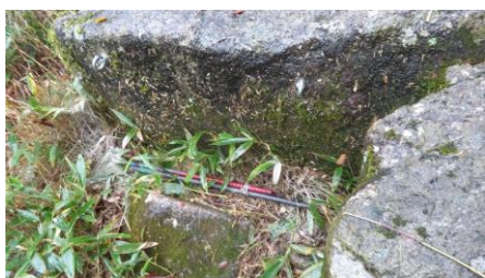
梯子取付のためのアンカー
