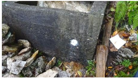
排水口を改良
