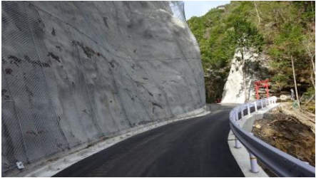
村道の開通箇所
