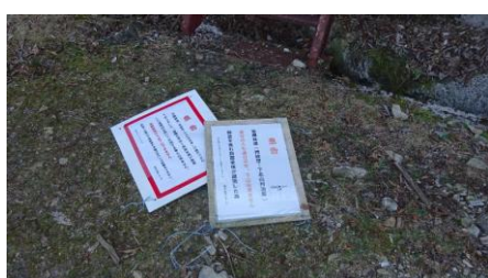
通行止め看板を取り外す
