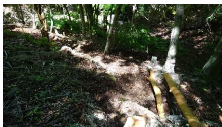
迂回路を新設
