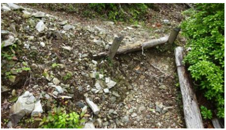
今日の改修箇所
