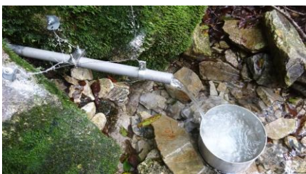
ステンレス線で吊下げ
