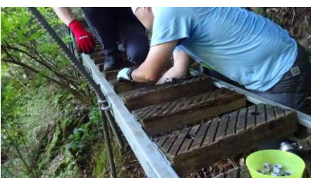
踏み板を外す
