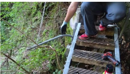
損傷現場に着く
