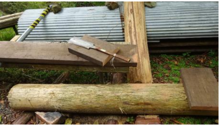
足場板を切る
