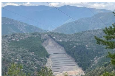
14番鉄塔から崩壊地を振り返る
