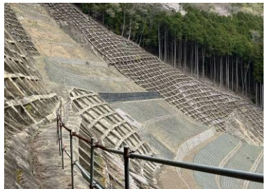
崩壊地修復跡
