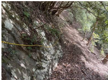
整備された箇所の一部
