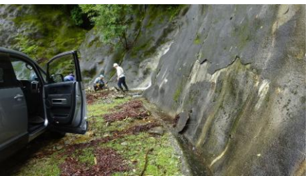
荒れた路面を補修
