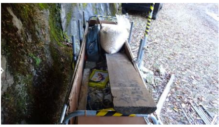
足場板を運ぶ
