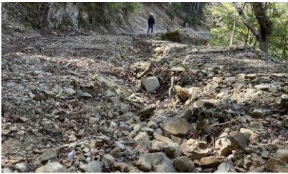
白谷林道の状況
