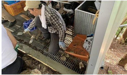
モルタル施工中
