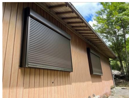
東側窓の雨戸
