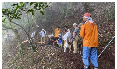
補給路拡幅作業
