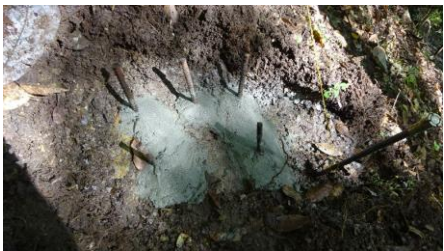
鉄筋をモルタル施工
